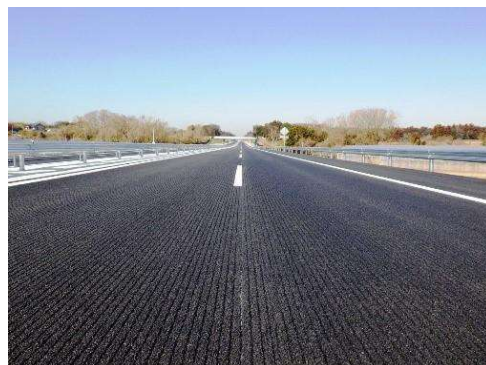
縦溝が特徴的なフル・ファンクション・ペーブ(FFP)の 路面
